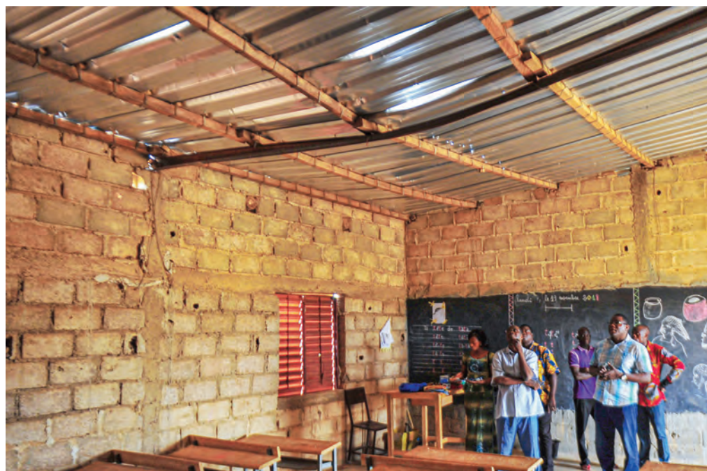
IL TETTO DELLA SCUOLA DI YAGMA (BURKINA FASO) DOPO UNA RAFFICA DI VENTO DI RARA VIOLENZA
